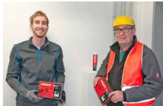
Geschäftsführer Walter Baum (re.) und Installateur Anton Giggenbach verbauen verstärkt den Brandschutzstein Hilti „CFS-BL P“ zur Abschottung von Kabeln und Rohren.
