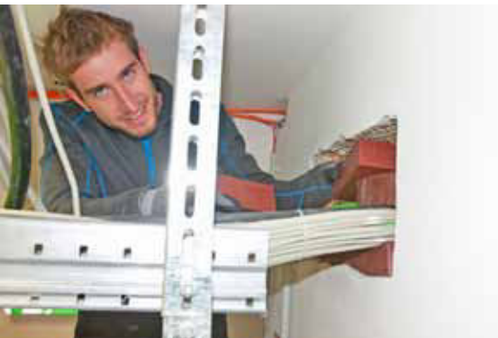
Die Durchführung mit Kabeln aus der Schaltzentrale eines künftigen Depots in München lässt sich mit dem Hilti Brandschutzstein einfach abschotten.
